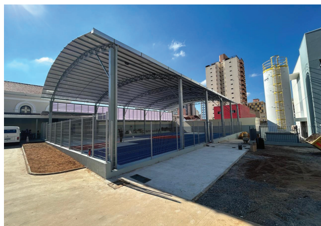
Quadra do Núcleo São João Batista finalizada e pronta para uso
