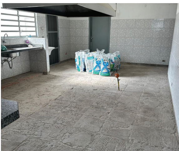
Reforma da cozinha do Núcleo Dom Bosco
