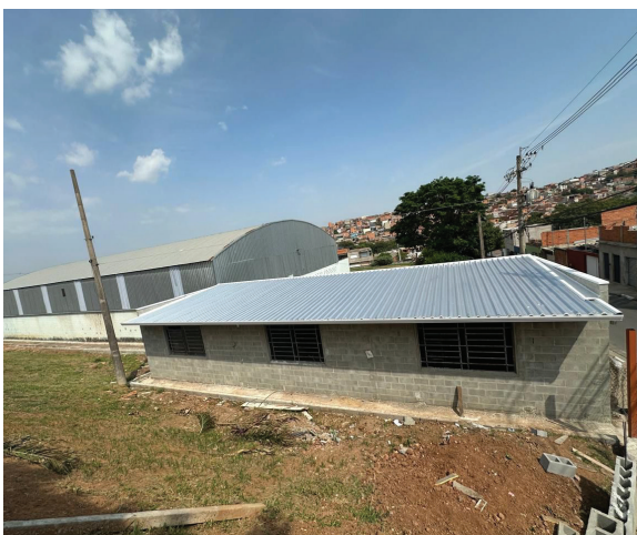
Salas de atividades em processo de finalização
