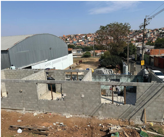
Construção de 3 novas salas no Núcleo N. Sra. Auxiliadora
